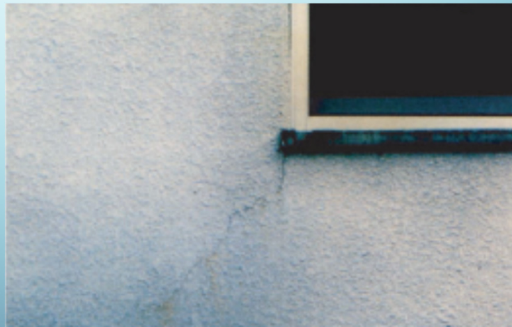
建物窓隅角部
