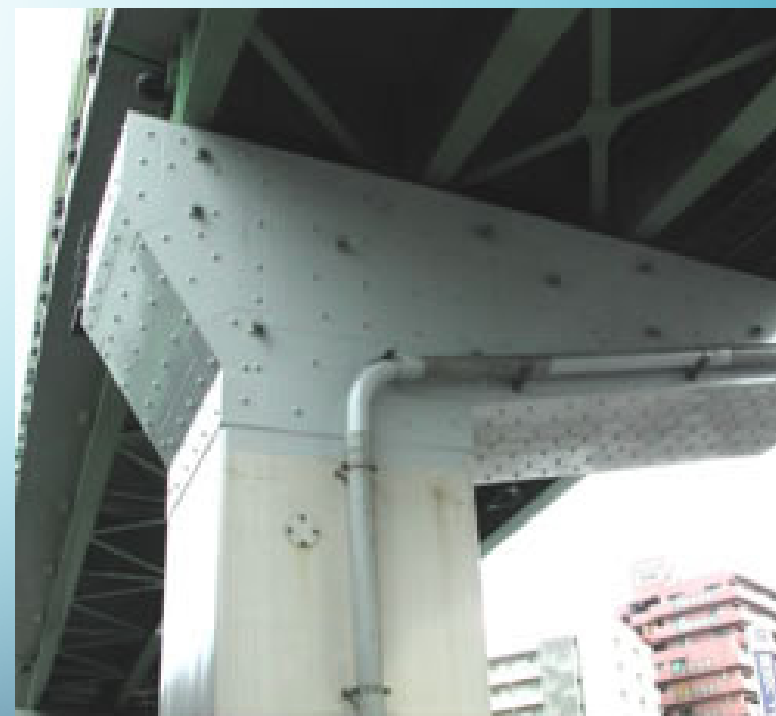
鋼板巻立て工法による補強事例
