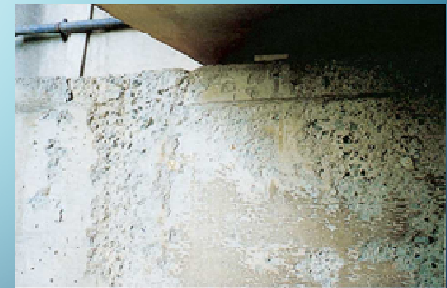
図 2.3 橋台に生じた凍害の事例
