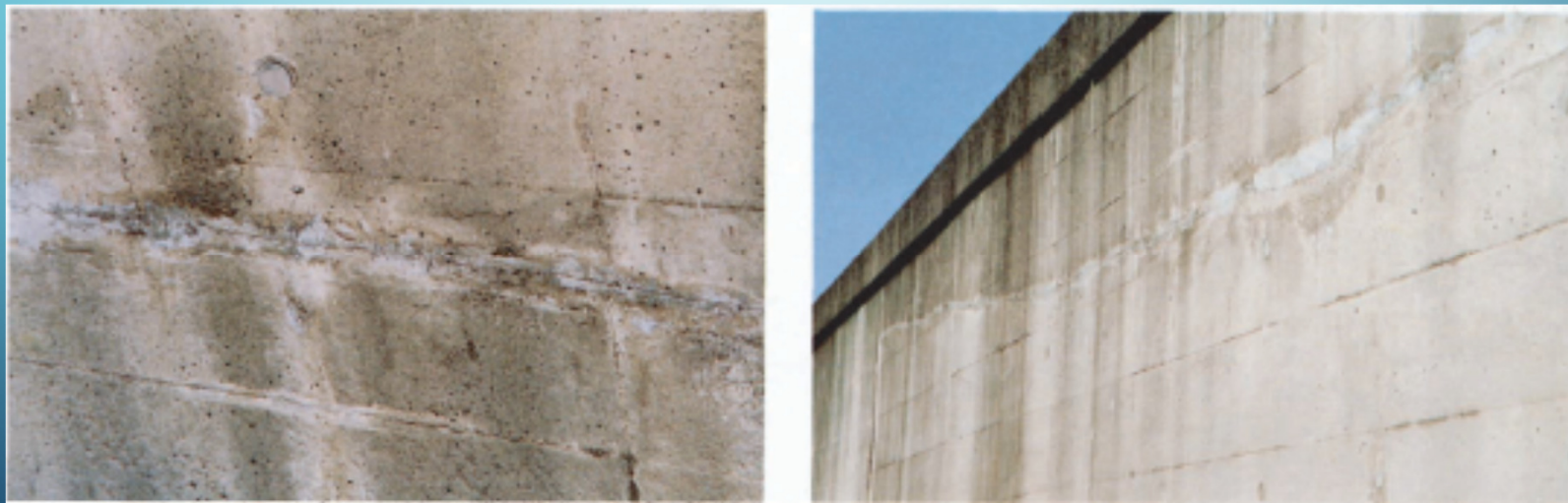
擁壁の打継部
