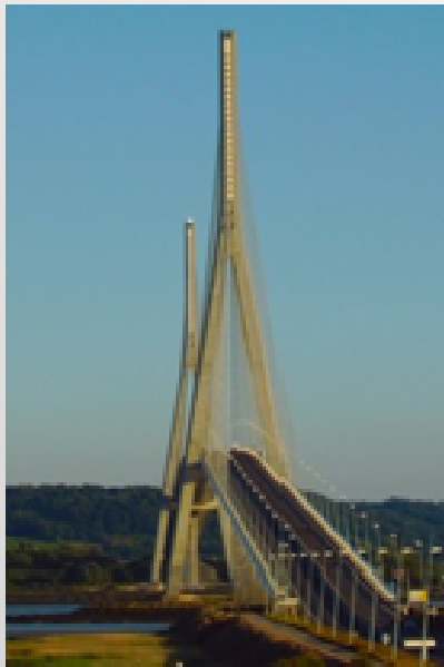
(c) 斜張橋主塔—フレーム構造
