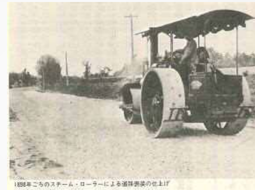
スチームローラーとマカダム道路
